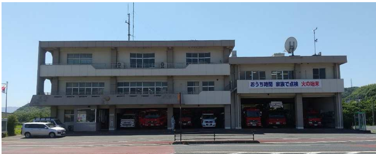
消防庁舎正面より
